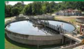
ETP, STP, WTP, RO & ZLD Installation;
